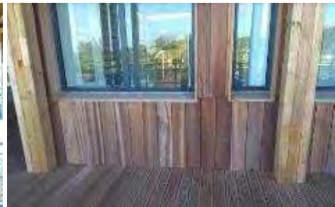
Boiseries avec usure prématurée
